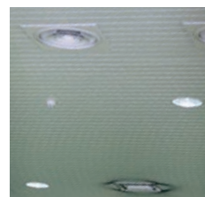
テレポートセンター駅天井
