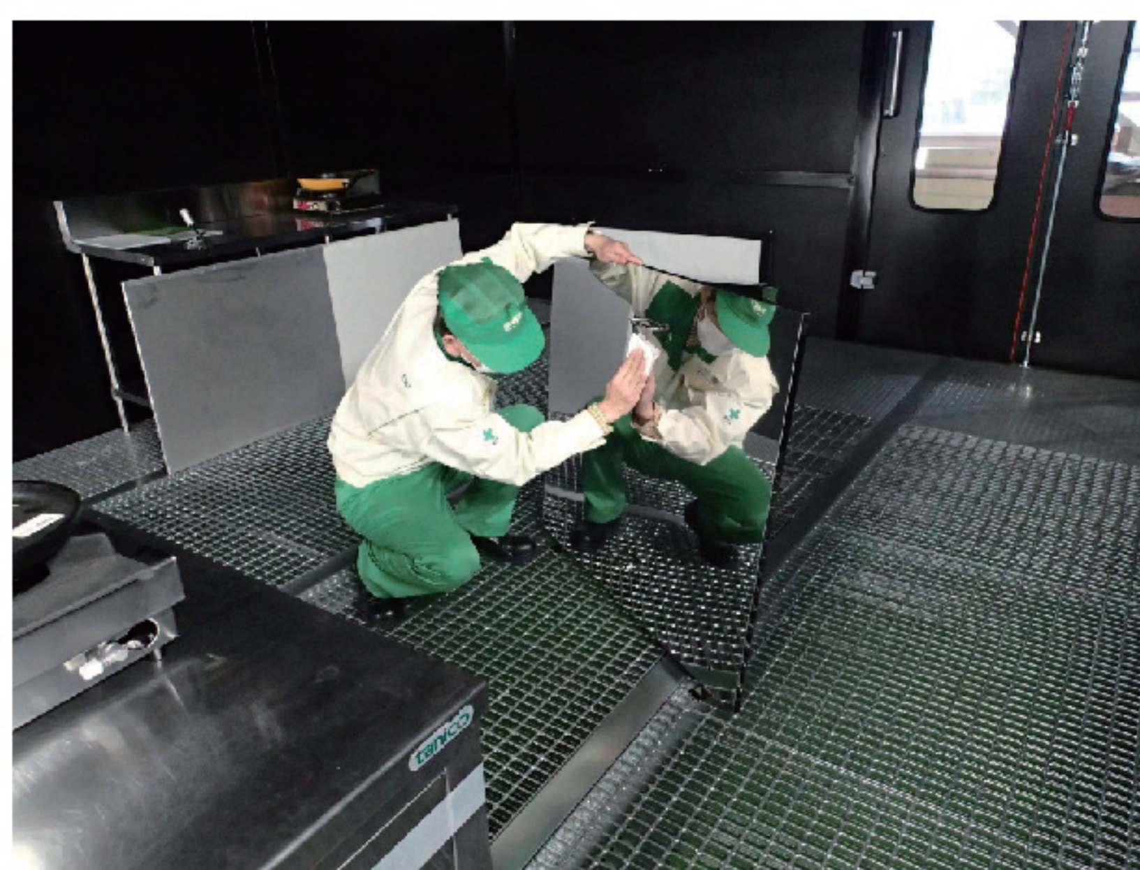
⑦厨房側溝近くで洗剤、水により洗浄
