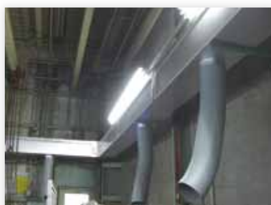
フレキシブルダクト取付施工例
