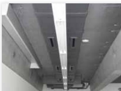
ダクトの塗装も可能(現場にて)
