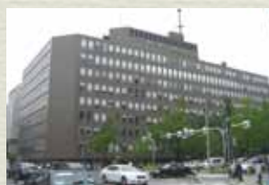
御堂ビル改修工事(大阪府)
