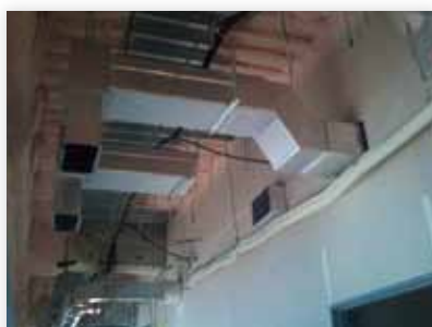
フレ管施工例
