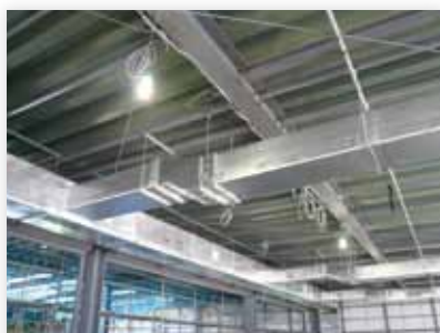
メインダクト、分岐ダクト施工例
