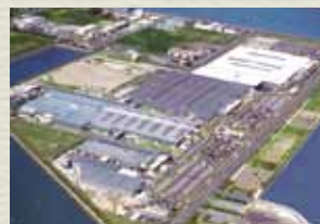
トヨタ自動車九州株苅田工場(福岡県)
