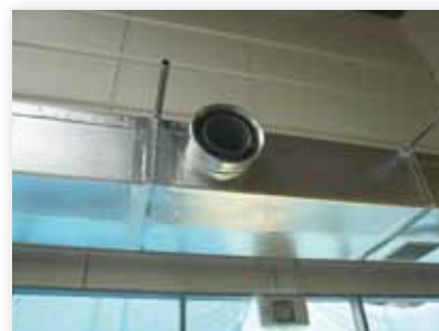
吹出口取付施工例
