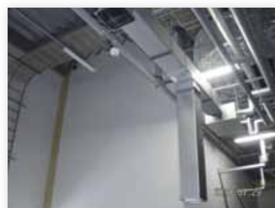
垂直ダクト取付施工例
